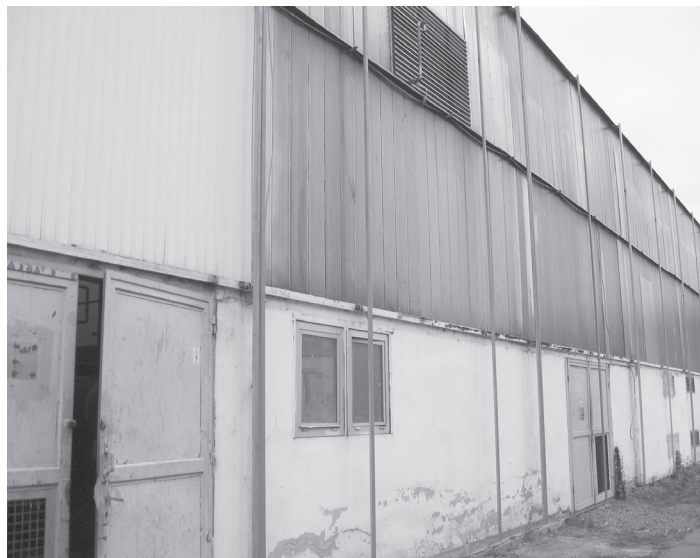
Výrobná hala pred modernizáciou a zateplením obvodového plášťa.
