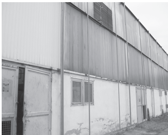
Výrobná hala pred modernizáciou a zateplením obvodového plášťa.
